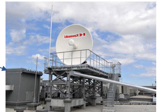
開口径3.7m パラボラアンテナ
